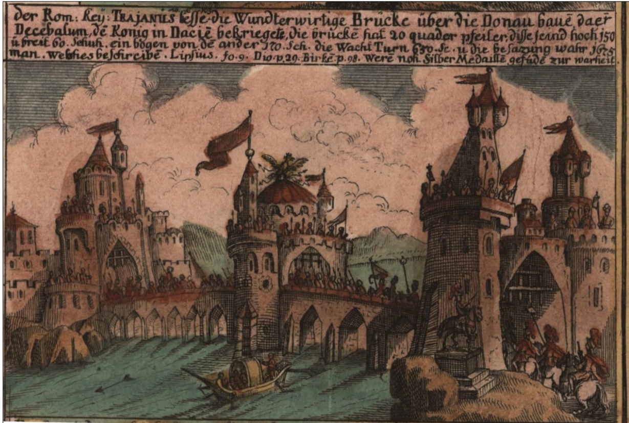
Ausschnitt aus einer Donaukarte (um 1738) mit einer fantasievollen Darstellung der Trajansbrücke, die von Apollodorus von Damaskus errichtet wurde Quelle: Wolf/Zimmermann (Hgg.): Fließende Räume, S. 175.
